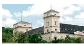
Zámek Račice, přestavba
